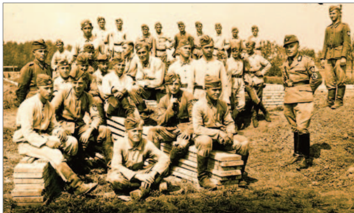
Frühe Vorbereitungen für den Krieg: Eine Gruppe des Reichsarbeitsdienstes (RAD) auf einer Bunkerbaustelle bei Memprechtshofen. Foto: Verein für Ortsgeschichte Memprechtshofen/Repro: Josef Budai
